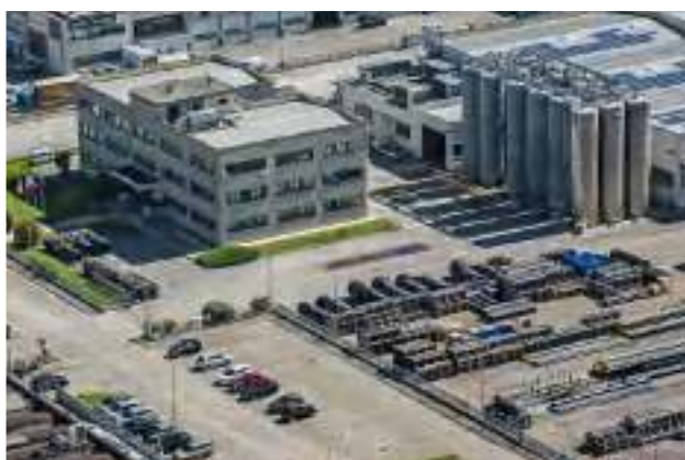
Centro Operativo - Castel Guelfo di Bologna (BO)
